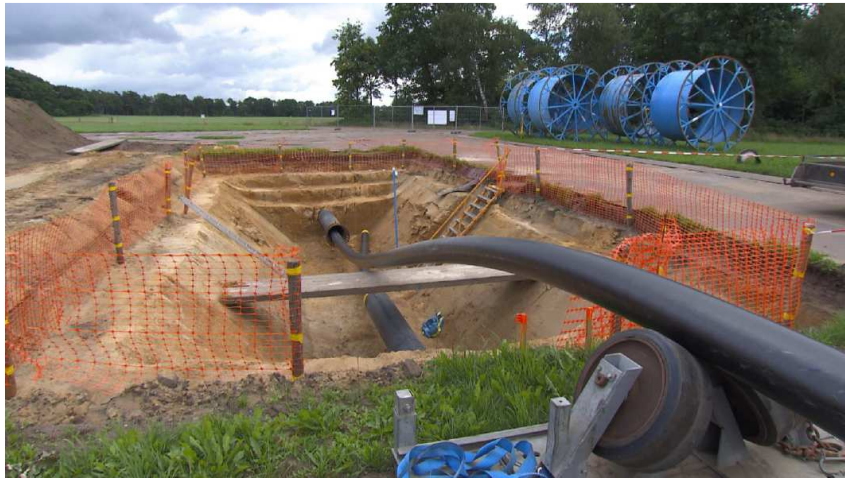
Рисунок 12 – Реконструкція трубопроводу протягуванням в нього гнучкої композитної труби
