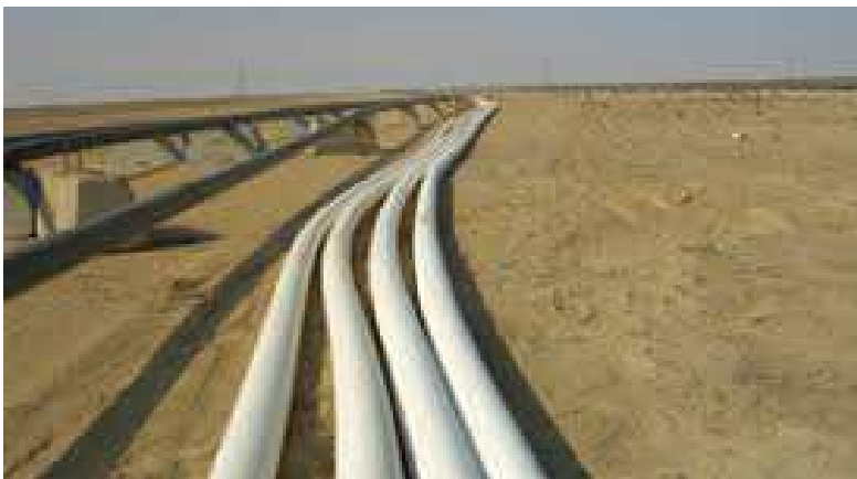
Рисунок 11 – Наземно прокладені гнучкі композитні трубопроводи
