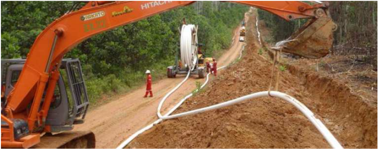
Рисунок 9 – Укладання гнучкого композитного трубопроводу одноковшовим екскаватором
